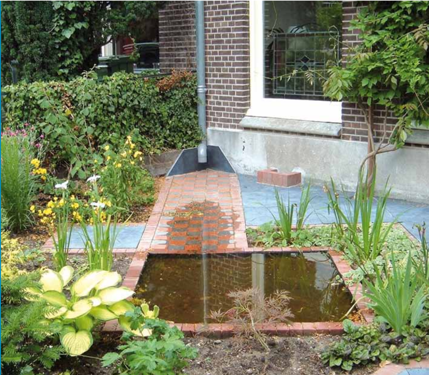
Figuur 4.7.2. Afkoppelen van hemelwater en opvang in de vijver. (Haags Milieucentrum)
