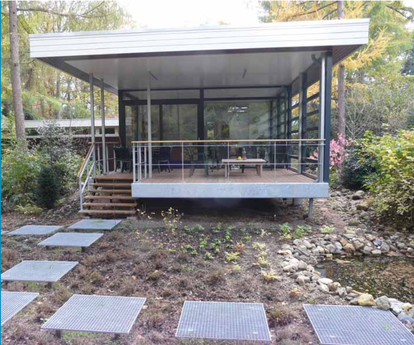
Figuur 4.1.16. Open staptegels op pootjes. (Douwe Snoek) Verhoogde staptegels veroorzaken minder belasting voor de bodem. De bodem wordt niet samengedrukt en bodemleven blijft intact.
