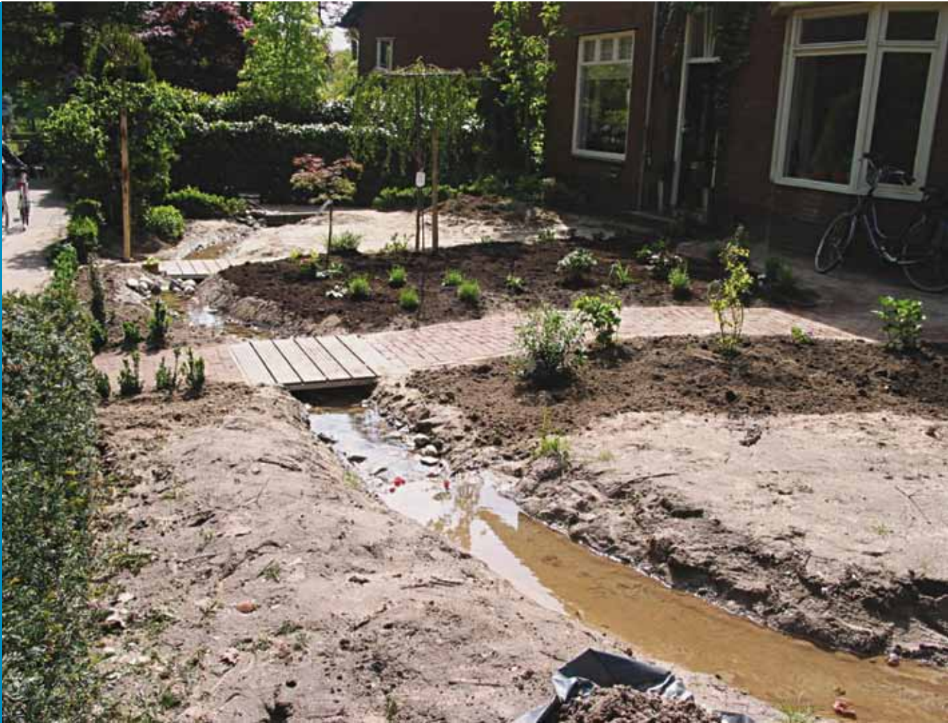
Figuur 4.4.8. Een wadi voor vele deuren. (Haags Milieucentrum) Wadi's worden steeds meer aangelegd om het hemelwater lokaal te bergen. Het is zinvol om dat met de hele straat of het woonblok te doen. De tuin wordt gedeeld met de burens. De levende tuin is dus geen geïsoleerd eiland maar wordt onderdeel van een groter geheel.
