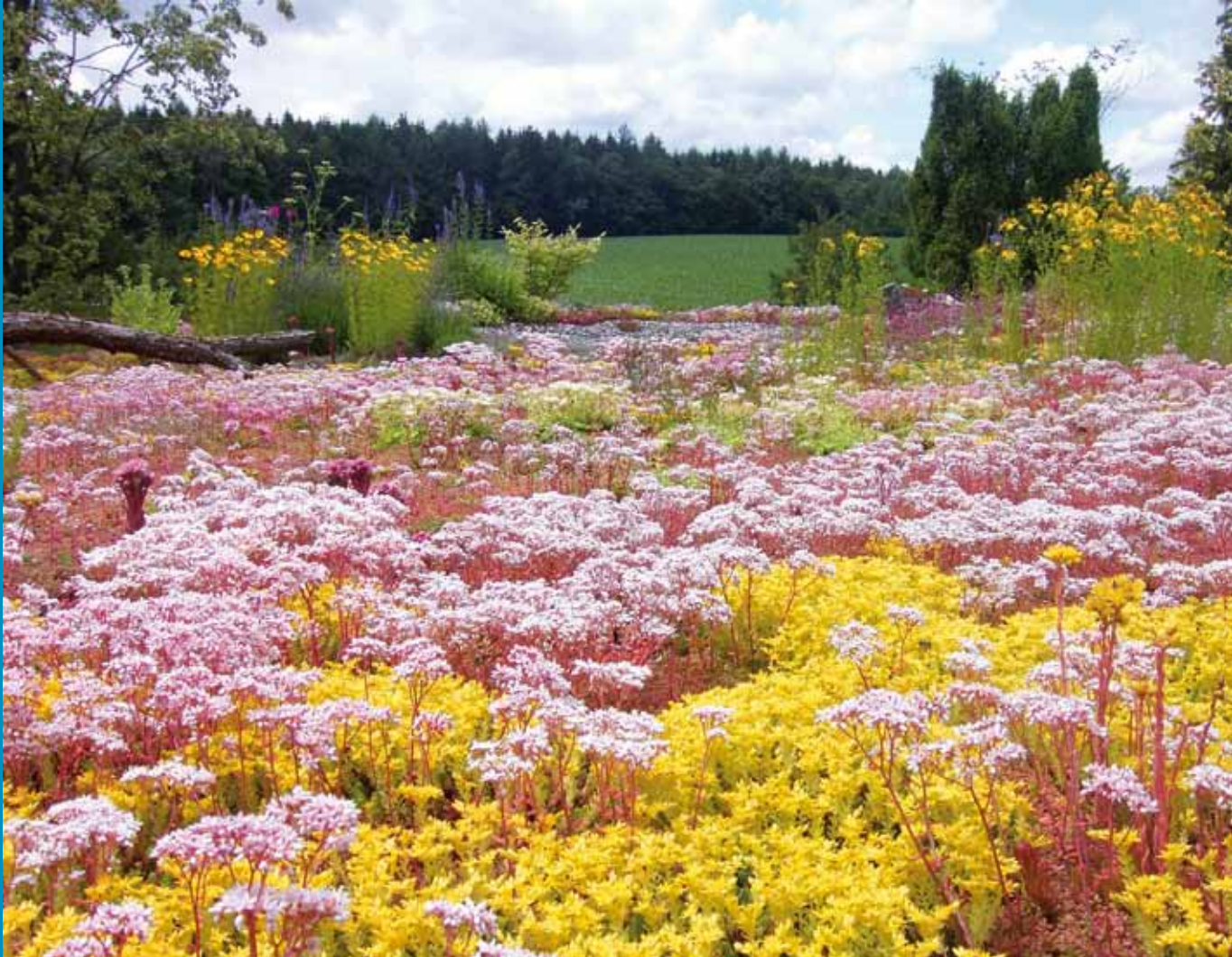
Figuur 4.2.16. Dakgroen verwerkt minimaal 50% van de neerslag. (Jaco Remmelink)
