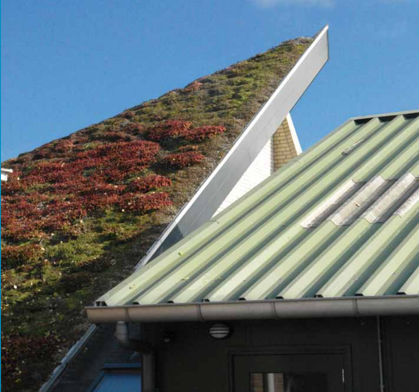
Figuur 4.6.2. Gebruik dak- en gevelgroen voor een lagere energierekening. (Nico Wissing)
